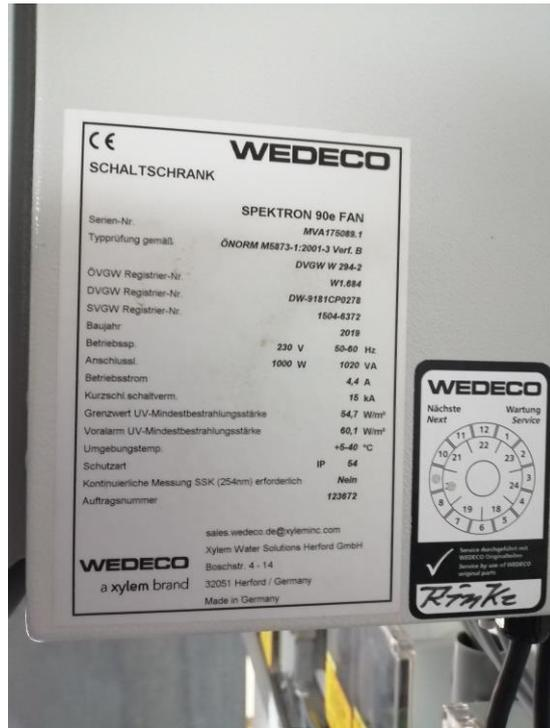
Abb 5: Schaltschrank-Prüfschild
