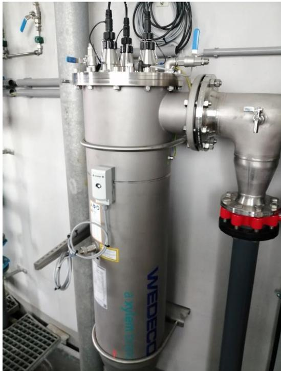
Abb. 4: UV-Desinfektionsanlage AU
